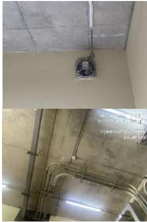
เครื่องตรวจจับควันและพัดลมระบายอากาศภายในห้อง MDB
