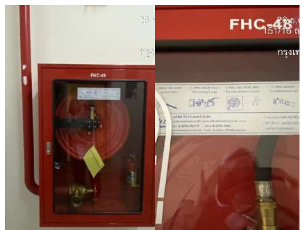
ตู้เก็บถังดับเพลิงสายฉีดน้ำ ท่อเย็นและวิธีการใช้งาน
